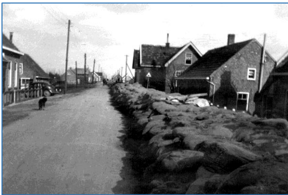
Zandzakken aan de Oud Bonaventurase dijk.
