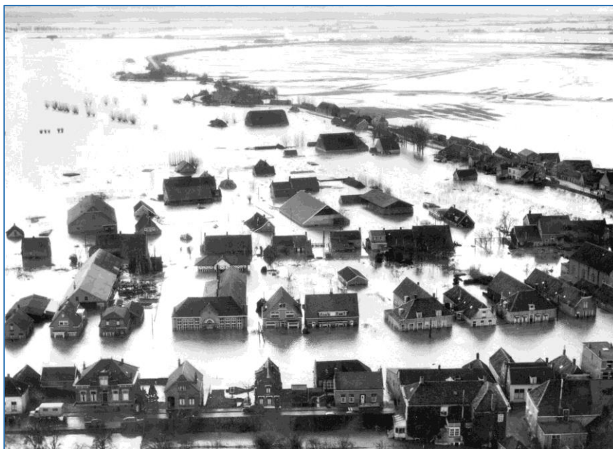
Luchtfoto van het gebied Haven en Schenkeldijk met achterliggende polder.
